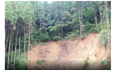
3. 被災箇所詳細の撮影
