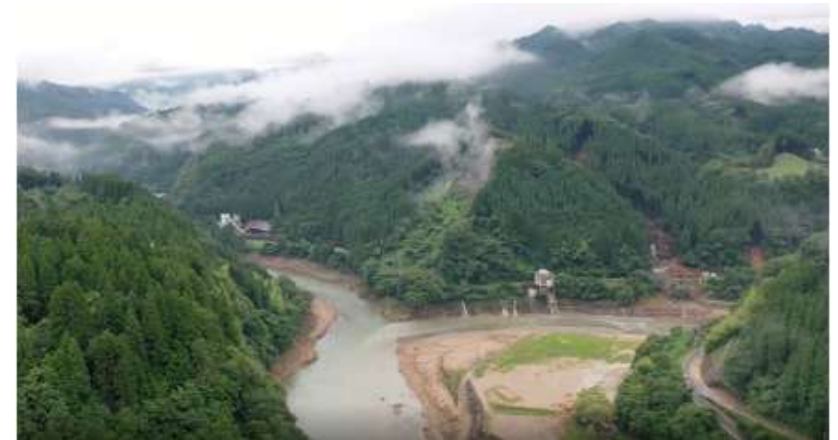
被災箇所の周辺を撮影した様子
