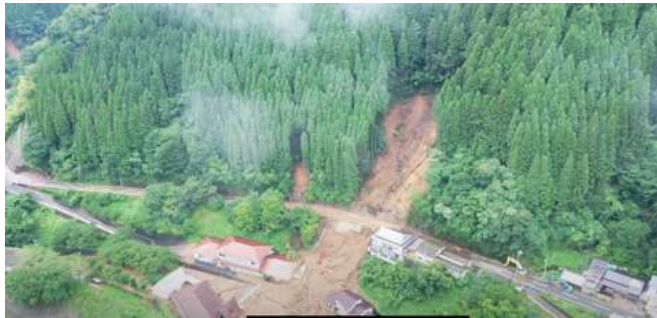
1. 被災箇所全容の撮影
