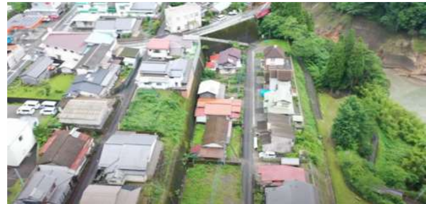
人家等への被害を撮影した様子
