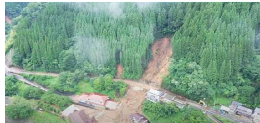
被災箇所全容を撮影した様子
