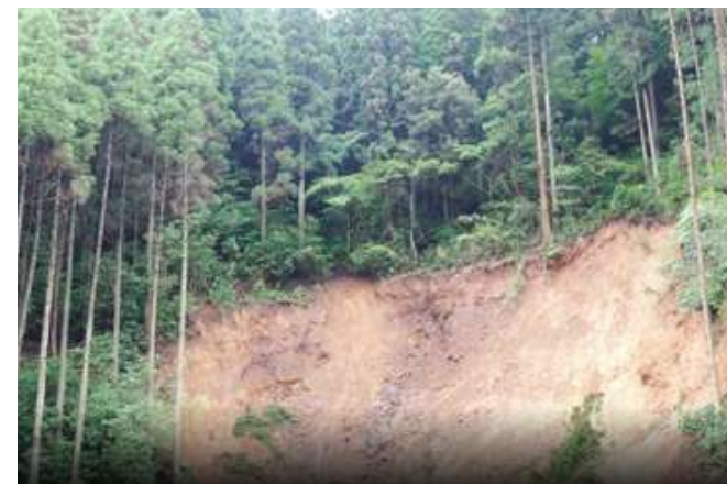
被災箇所の詳細を撮影した様子
